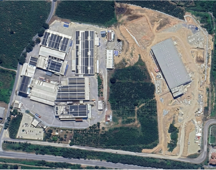
Fotoğraf 2: Balsu Hendek Fabrikası & Hendex Fabrikası İnşaatı
