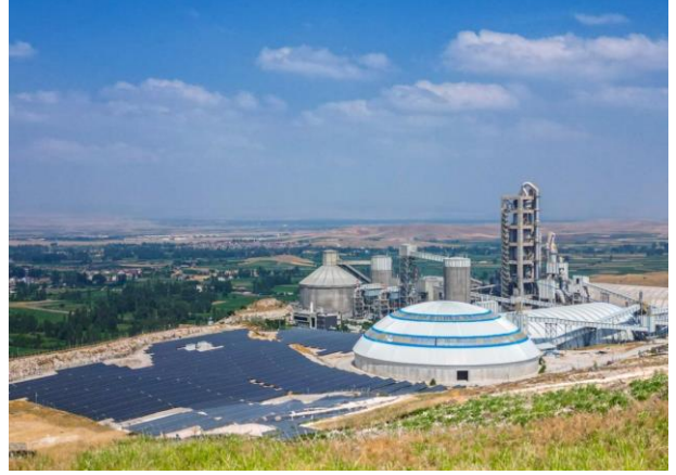
Görsel 2: Çimsa Afyon Fabrikası
