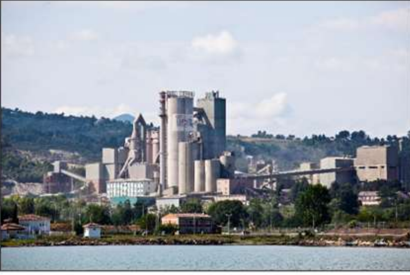
Ünye Çimento Fabrikası
