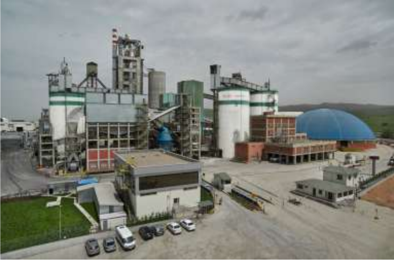
Aslan Çimento Fabrikası
