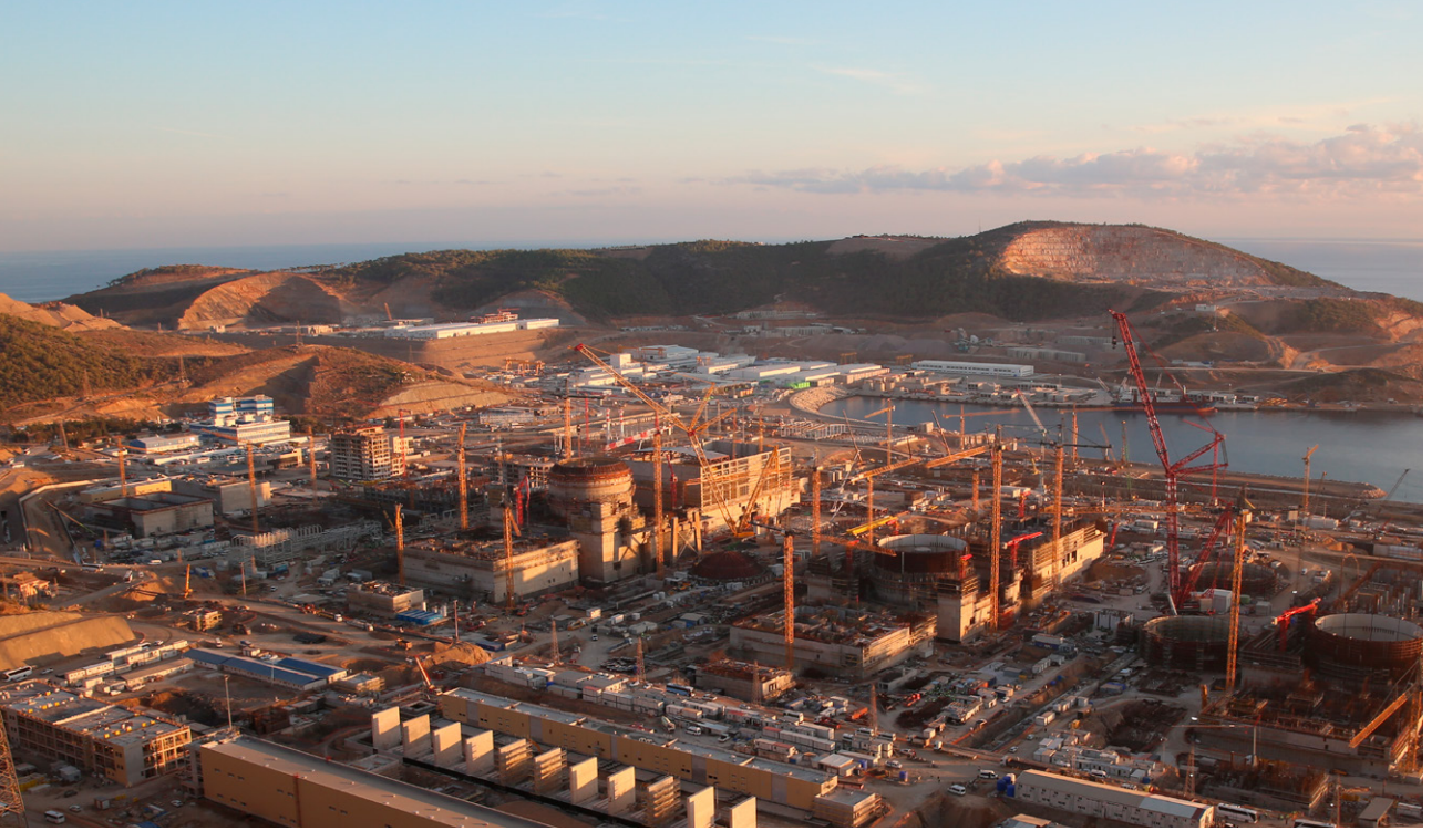
Şekil 1: Akkuyu NGS Sahası
